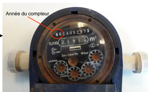
Compteur eau potable Syndicat des eaux
